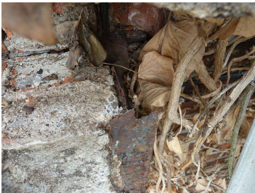
Figur 9. Brudsnittet i det højre (set udefra) udliggerjern set mod altanpladen. Her ses det stærkt nedbrudte tværsnit.
