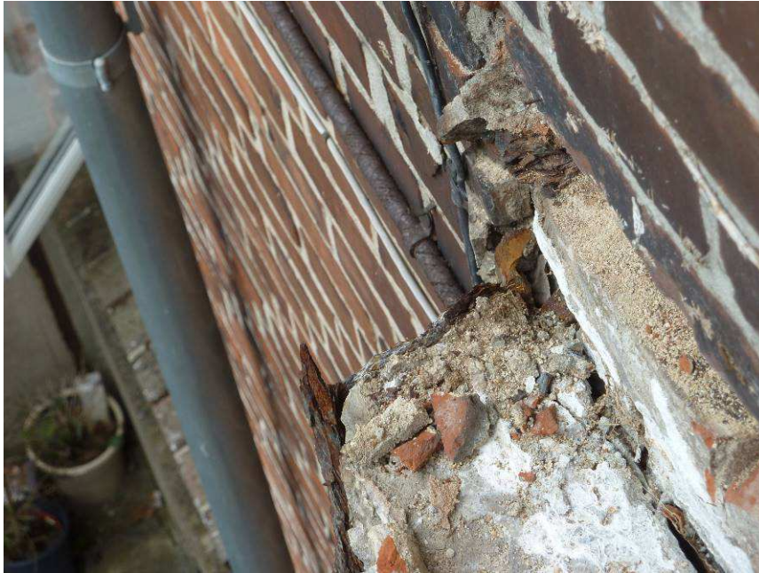
Figur 7. Brudsnittet i det venstre (set udefra) udliggerjern set mod altanpladen. Her ses det stærkt nedbrudte tværsnit.
