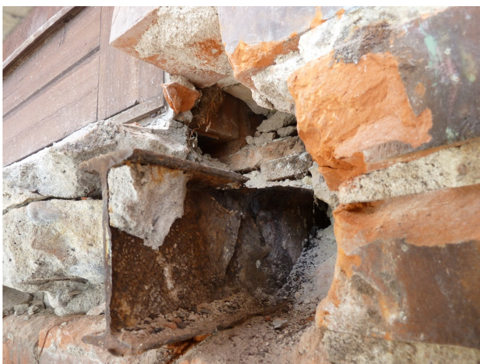
Figur 12, Før ophugning ved udliggerjern, altan i stueetage.
