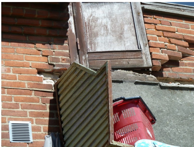
Figur 4 Udstøbning under døråbning
