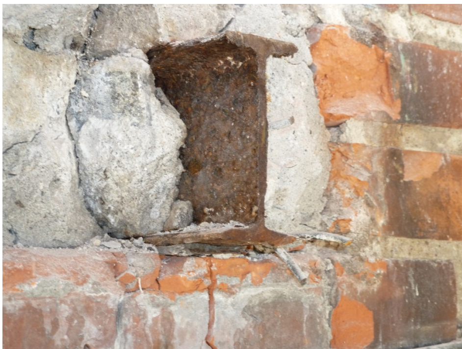
Figur 12, Før ophugning ved udliggerjern, altan i stueetage.
