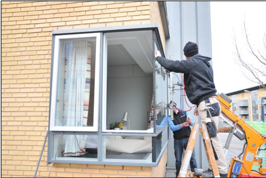
Udbedring af stepvindue hvor glas er limet sammen i hjørnet.
