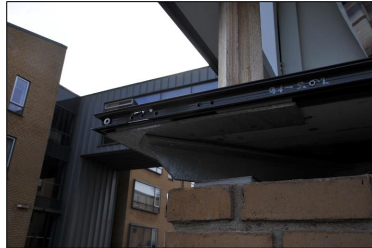
Ny understøtning af hjørne
